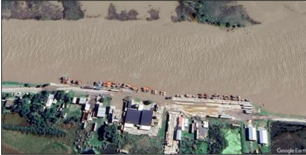
Figura 18. Vista aérea del puerto de General Lavalle. Fuente: material documental
