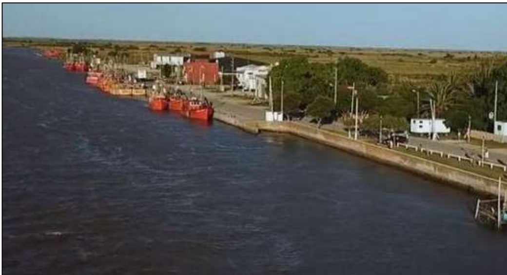
Figura 19. Vista aérea del puerto de General Lavalle. Fuente: material documental
