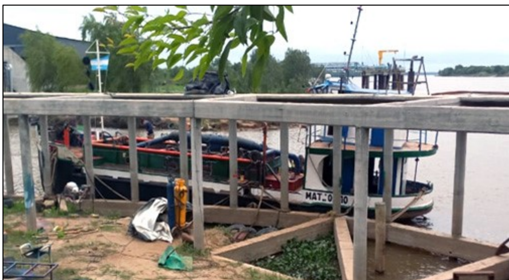
Figura 7. Se observa al B/M María del Carmen amarrado a la estructura costera donde ocurrió el suceso. Vista de la banda de babor. Se observan amarras tomadas a las columnas de la estructura de hormigón
