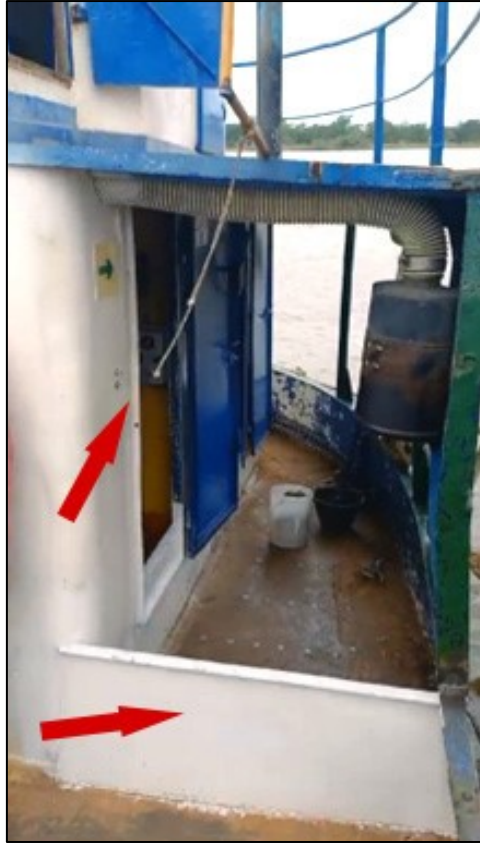
Figura 11. Pasillo por la banda de babor, se indican con flechas la porta de acceso a la sala de máquina (flecha superior) y el umbral de la abertura sin puerta que se construyó luego del suceso y que conecta la popa con la sección media del buque (flecha inferior)
