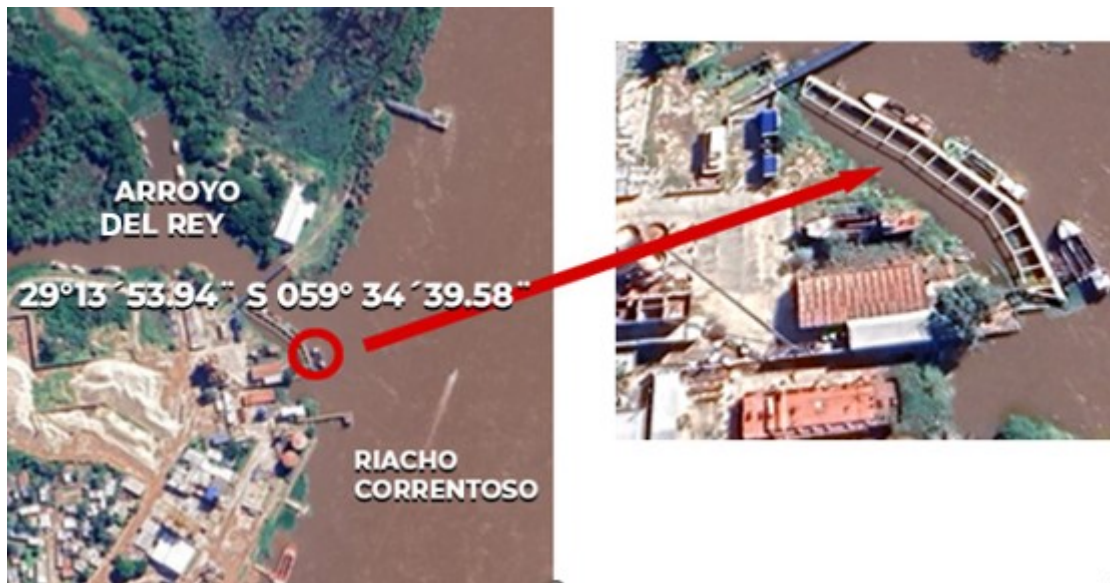
Figura 2. En la imagen de la izquierda se observa un círculo rojo señalando el lugar del suceso; aguas abajo se visualiza el Puerto de Reconquista. En la imagen de la derecha se puede ver una vista aérea de la estructura de hormigón donde estaba amarrado el buque
