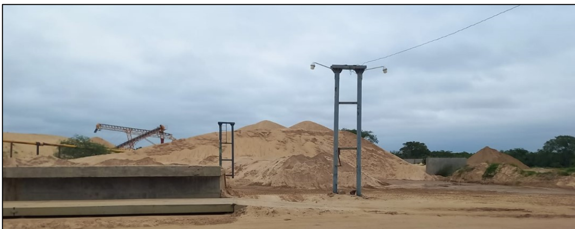
Figura 4. Zona de acopio de arena ubicada frente al sitio de amarre Fuente: material documental
