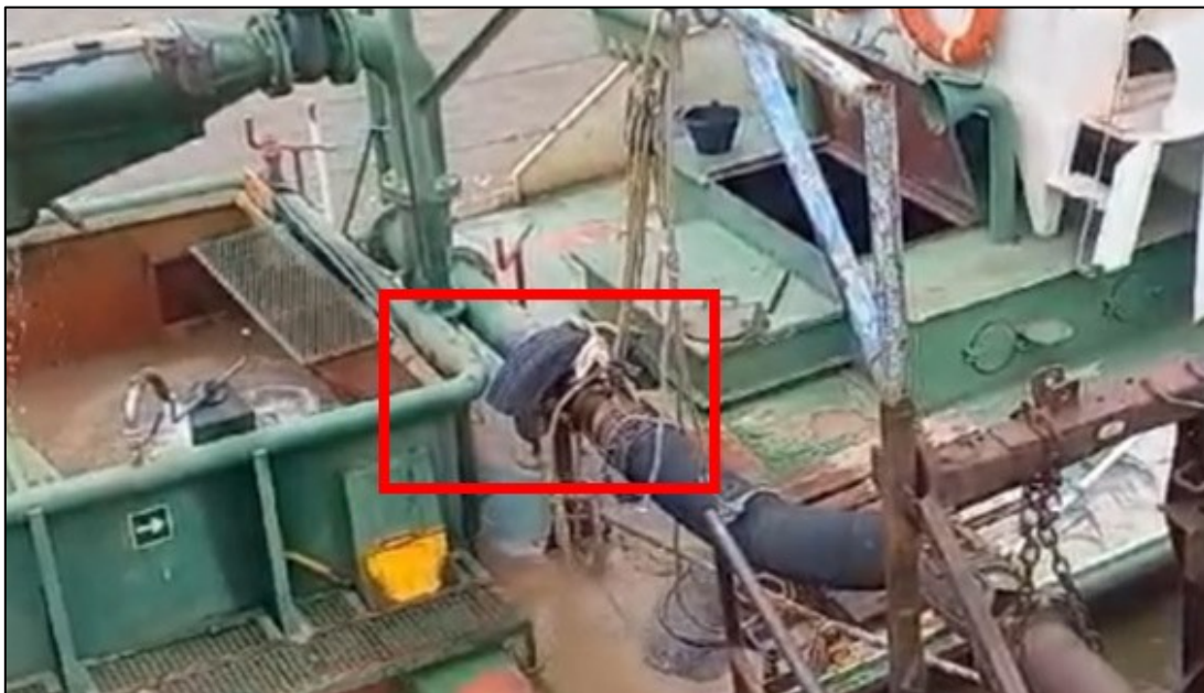
Figura 16. Conexión del manguerote para la descarga
