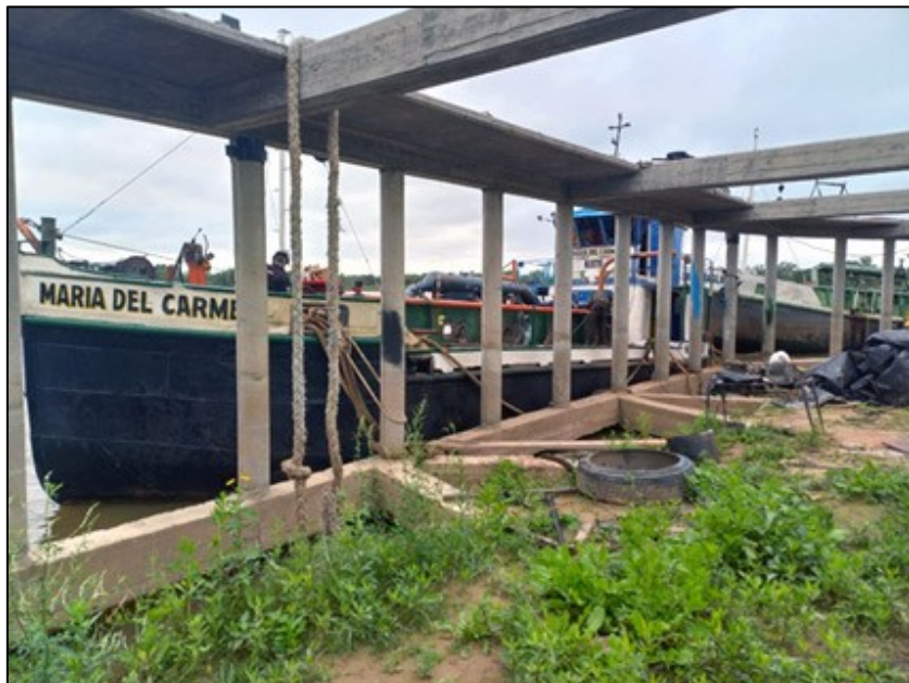
Figura 22. Estructura costera de hormigón que era utilizada para el amarre del buque. En la imagen se observan amarras tomadas sobre las columnas de esta estructura
