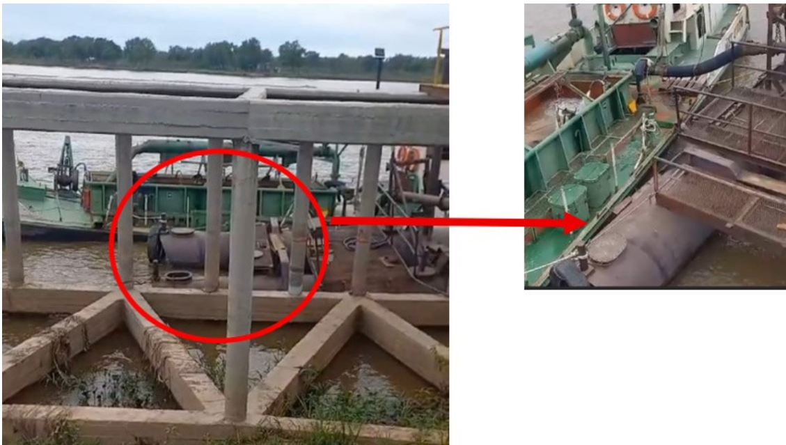
Figura 15. Estructura costera de hormigón donde ocurrió el suceso. Se observa en la imagen un pontón donde estaba atracado el arenero y por donde corría la conexión del manguerote para la descarga
