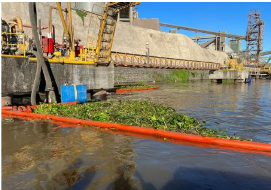
Figura 3. Se observa tendido de barreras de contención.
