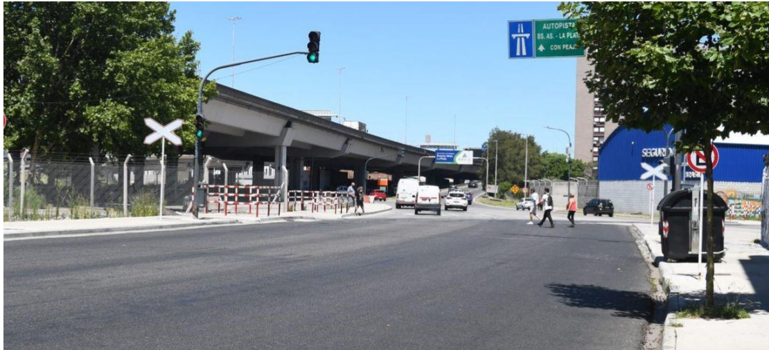
Figura 19. Calzada de Av. Huergo en proximidad del PAN. Se verifica ausencia de línea de detención.
