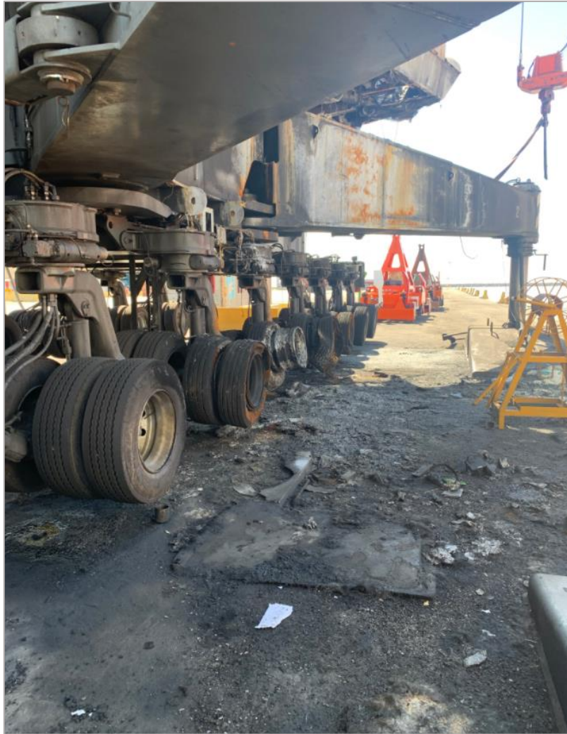
Figura 10. Vista lateral, zona baja con restos de material quemados.
