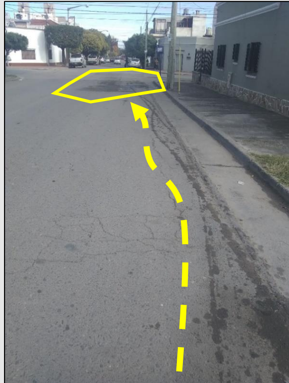
Figura 32. Diseminación de fluido con finalización en una mancha. Vista hacia el cardinal suroeste
