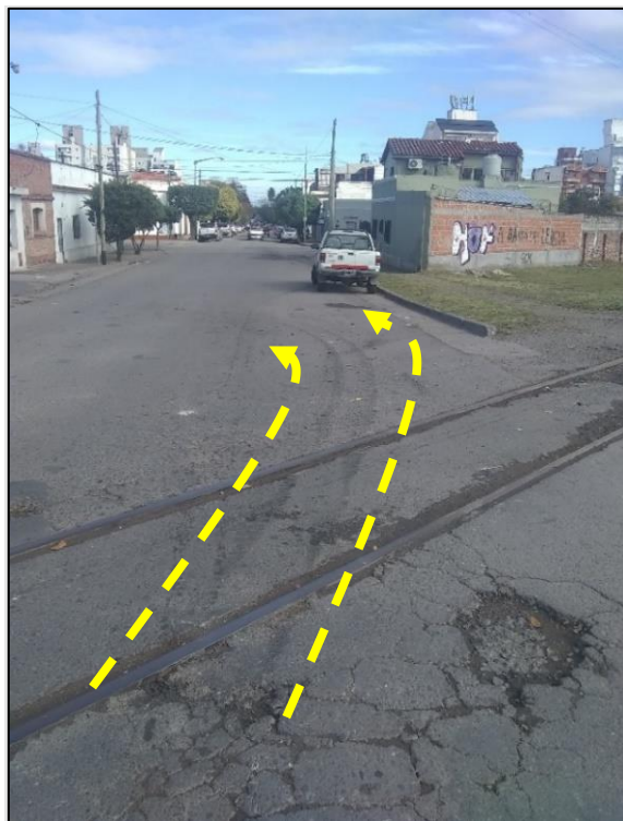
Figura 30. Huellas de derrape dejadas por el ómnibus urbano. Fuente: relevamiento JST, 2021
