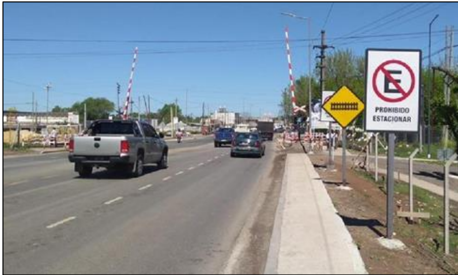
Figura 13. Señalización pasiva vertical (sentido Escobar hacia Pilar). Fuente: JST, 2021
