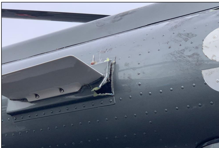
Figura 4. Daños en el cono de cola
