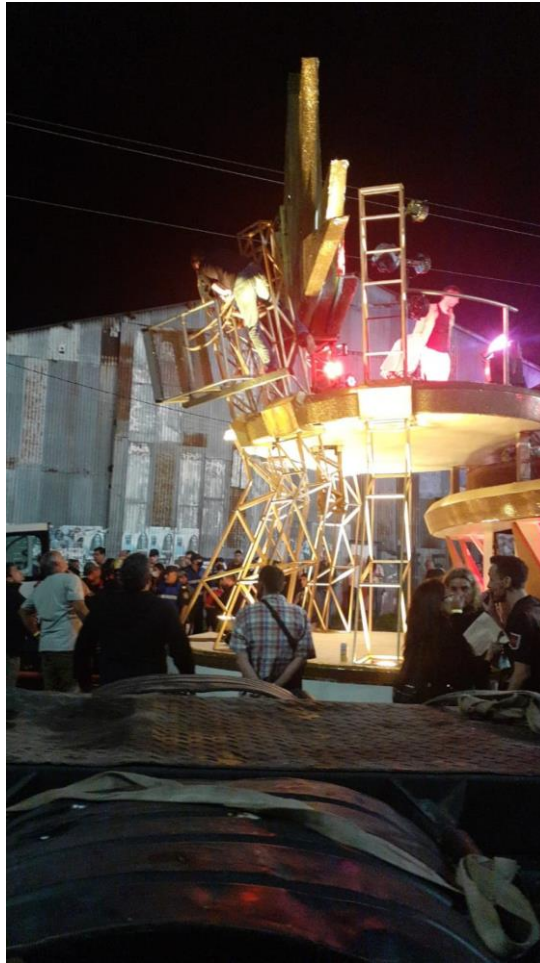
“Accidente en el carnaval de Gualeguaychú: dos operarios resultaron heridos tras caer de una grúa” Fuente: Infobae 6 de febrero, 2022.
