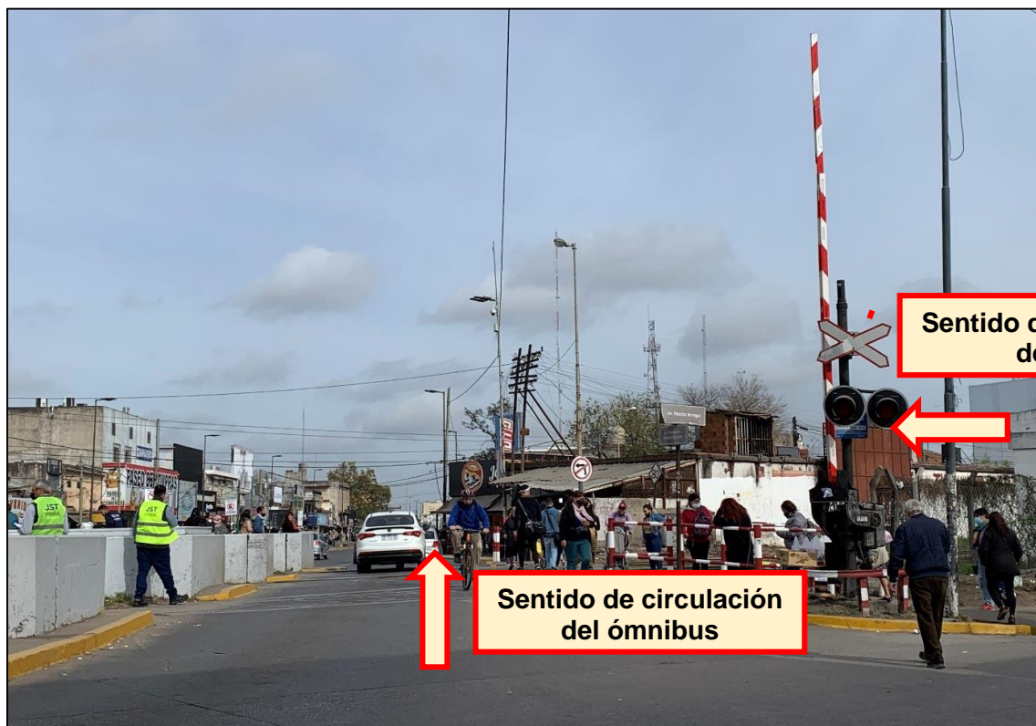
Figura 4. Vista del paso a nivel del incidente. Fuente: JST, 2022
