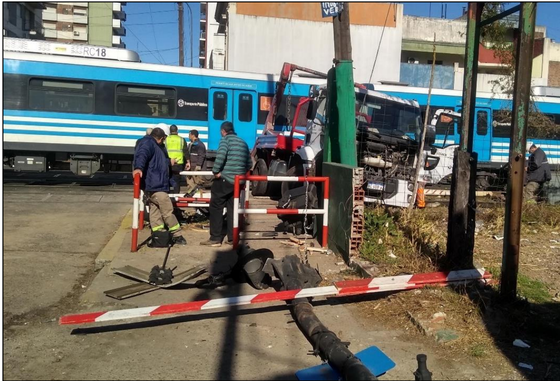
Figura 4. Daños en la infraestructura ferroviaria. Fuente: JST, 2 de julio de 2022
