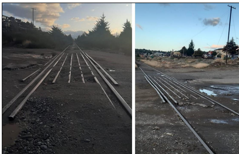
Figura 3. Asfalto en el cruce ferroviario
