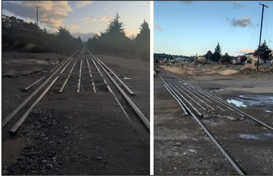
Figura 8. Asfalto en el cruce ferroviario. Fuente: relevamiento de campo JST, 2022
